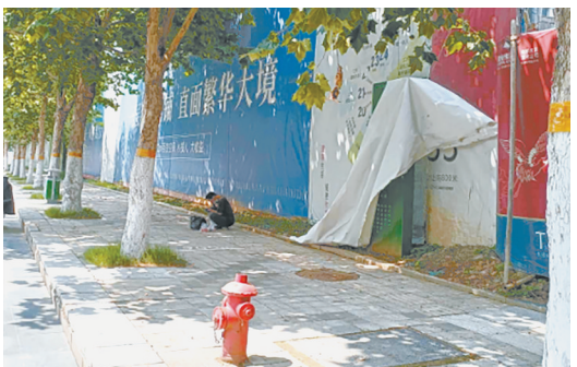
太白山中路与嘉陵江路交叉口向南约30米路西,云熙府工地围挡上的广告破损。
