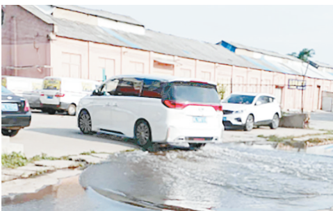
金江路与金山南路交叉口向西约280米路南，再向南约10米路东，排水管道堵塞。
