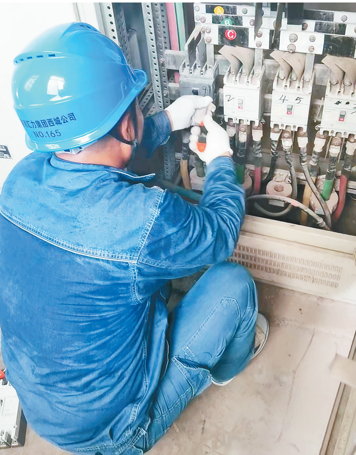
7月12日下午，国网漯河供电公司沙北供电部组织抢修队员在沙澧文景观苑小区抢修配电柜，更换空开及接线端子，保障用电。
