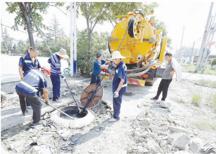
7月17日,郾城区住建局施工人员正在清理排污管道。
