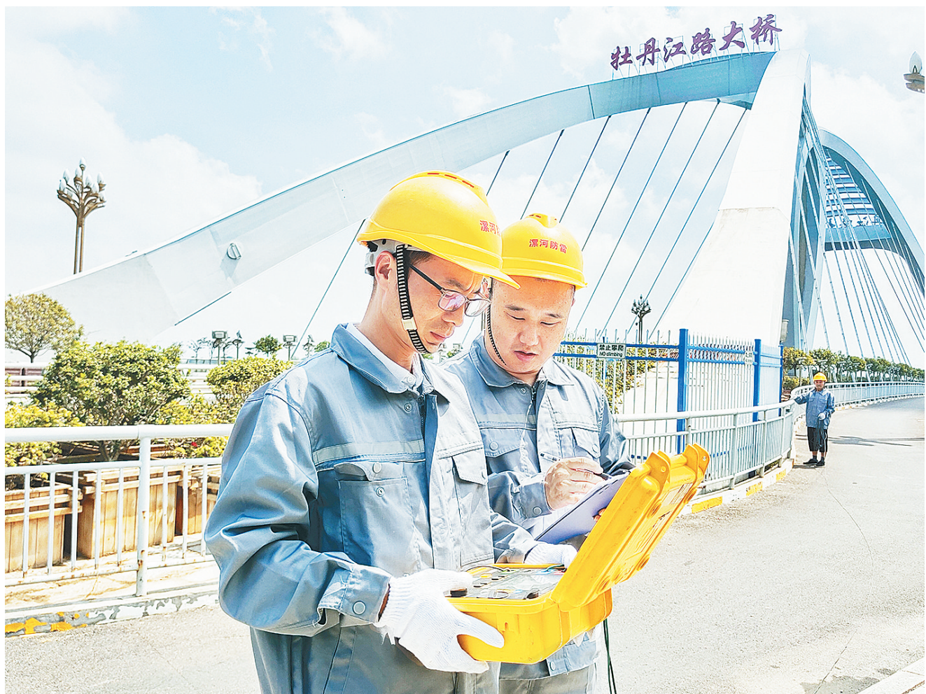
7月27日,市气象局组织技术人员对市区部分桥梁开展防雷安全检测,防止因雷击引发灾害事故,确保汛期桥梁安全运行。图为技术人员对杜丹江路沙河桥进行检查和检测。
