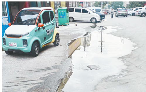
青河路与井冈山北路交叉口向西约40米路北，排水管道堵塞。
