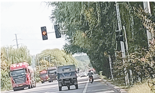
樟江东路与金山南路交叉口向西约200米路南，行道树枝叶遮挡交通信号灯。
