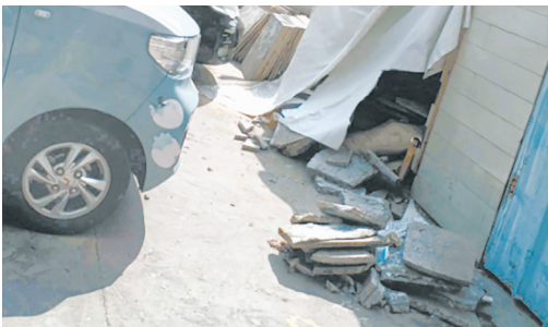
马路街与华平街交叉口向西约60米路南，建筑垃圾堆积。
