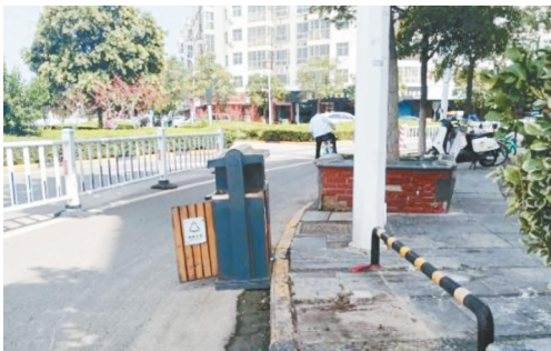
泰山南路与柳江路交叉口向南约10米路东，垃圾箱移位。
