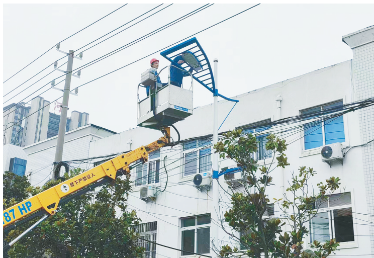
9月25日，路灯维护人员在交通路对路灯进行检修。
