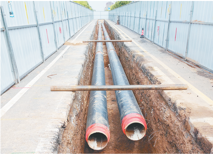
泰山路上新铺设的集中供暖管网。
