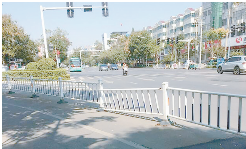
长江路与嵩山路交叉口西南角，交通护栏损坏。
