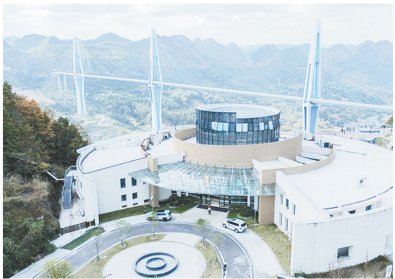
这是10月25日拍摄的贵州省平塘县“天空之桥”观光服务区（无人机照片）。
