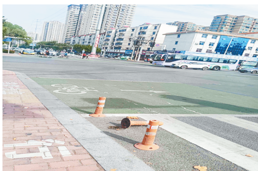
交通北路与黄河中路交叉口,人行横道桩倒地。
