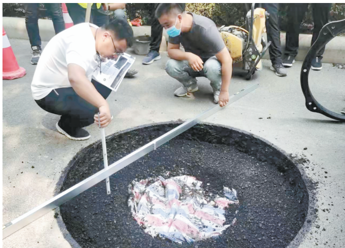
工作人员对窨井盖进行整治。
