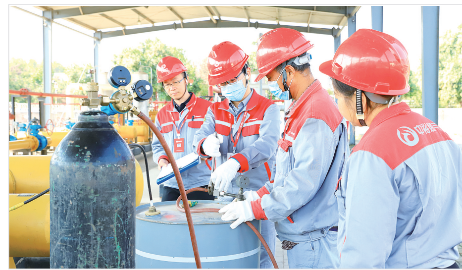
工作人员针对场(站)燃气设备设施开展安全检修。
