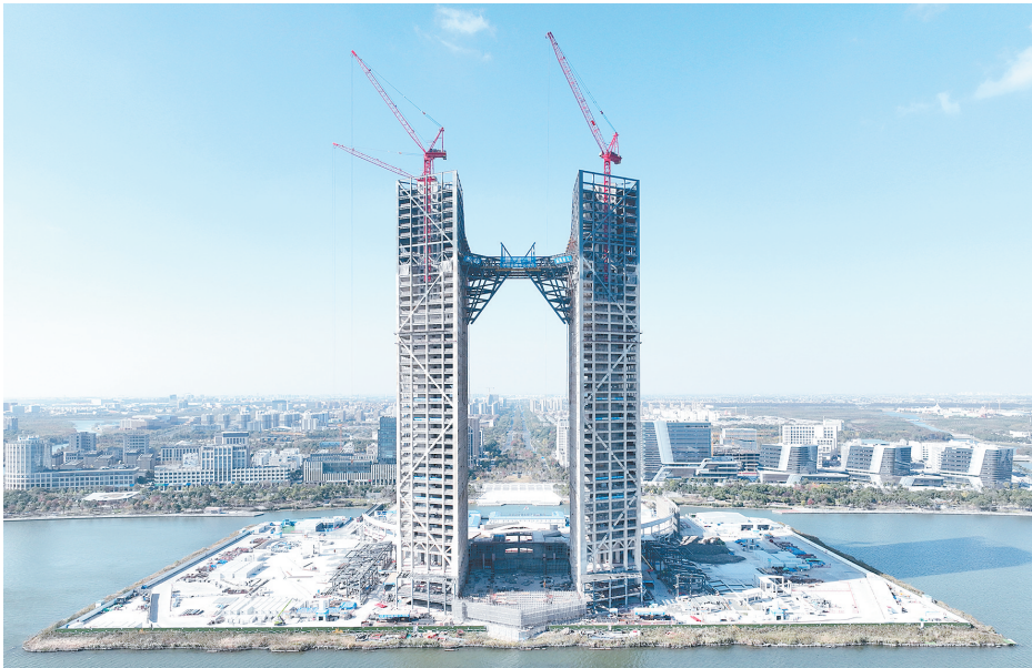
钢结构锥体提升完成的西岛中金金融中心项目南北塔楼（2023年11月24日摄，无人机照片）。 新华社记者 方 喆 摄
