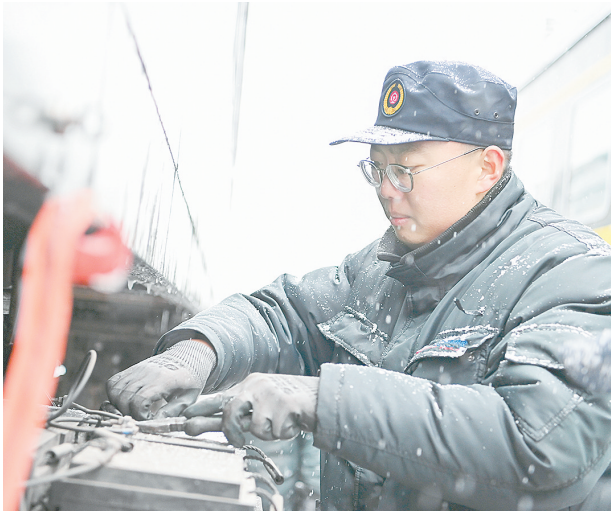
12月14日,工作人员在太原车辆段进行检修作业。
