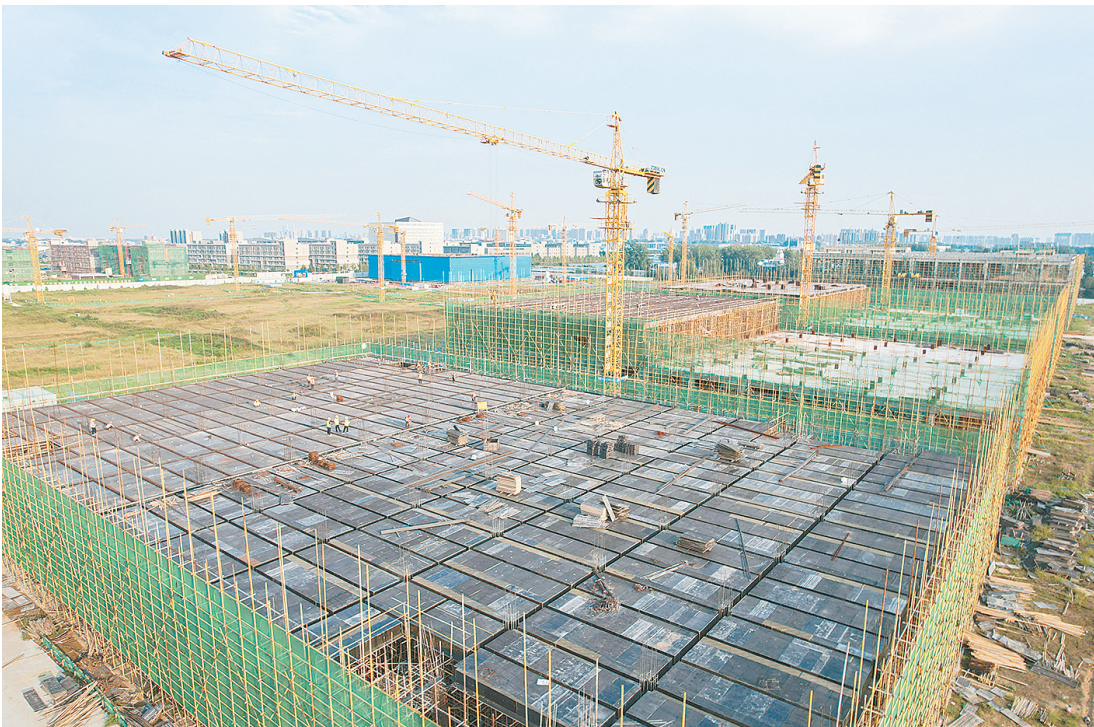
河南食品科创园项目施工现场。
