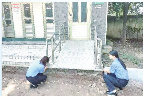
现场勘察无障碍设施
