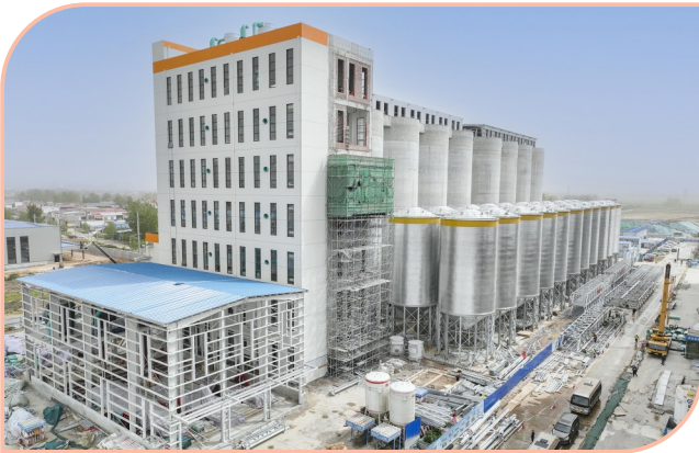
中粮粮谷90万吨小麦深加工项目
