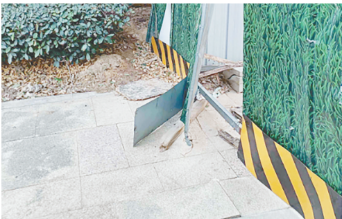
月湾湖东路与王屋山路交叉口向东约90米路南,长申玉住宅小区工地围挡破损。
