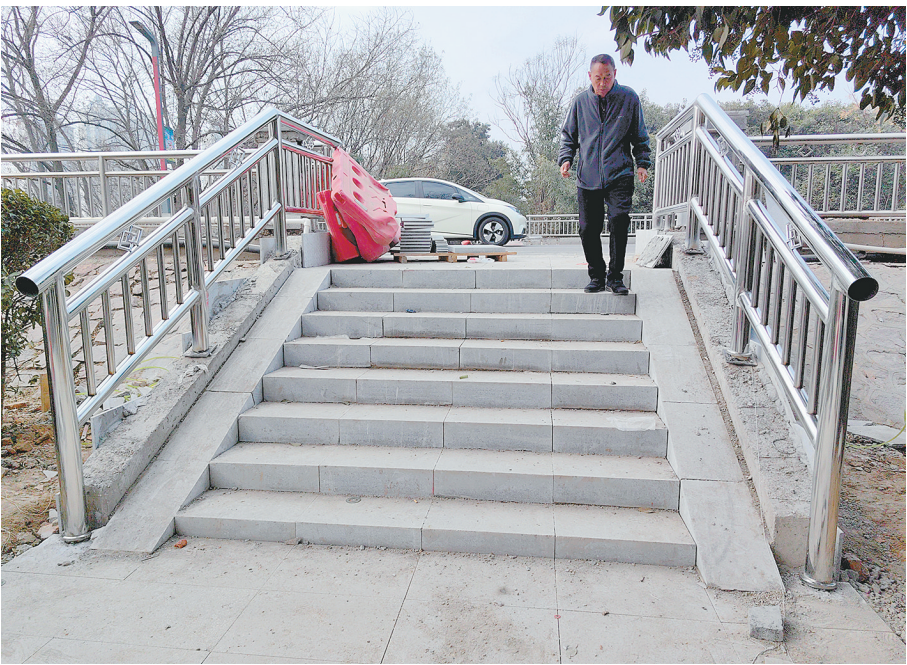
嵩山路沙河桥北段路东侧的河堤与桥面连接通道，台阶已铺设地砖并安装了栏杆。
