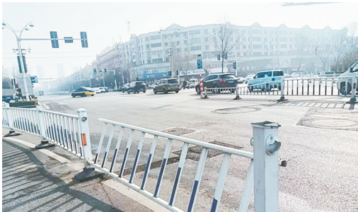
大学路与嵩山路交叉口向西20米路北护栏脱落。
