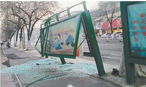
人民东路与光明路交叉口向东约120米路北，公交站亭损坏，影响通行。
