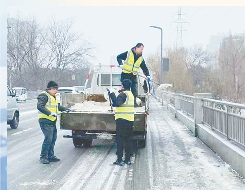
2月1日凌晨起,市政建设和公用事业服务中心组织人员对市区13座桥梁和5座立交抛撒融雪剂。截至目前,该中心共出动融雪剂撒布机3台,人员100余人次,抛撒融雪剂二十余吨。 本报记者 朱红 摄
