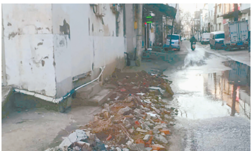
香山路与黄河东路交叉口向南约150米路东，渣土堆积。
