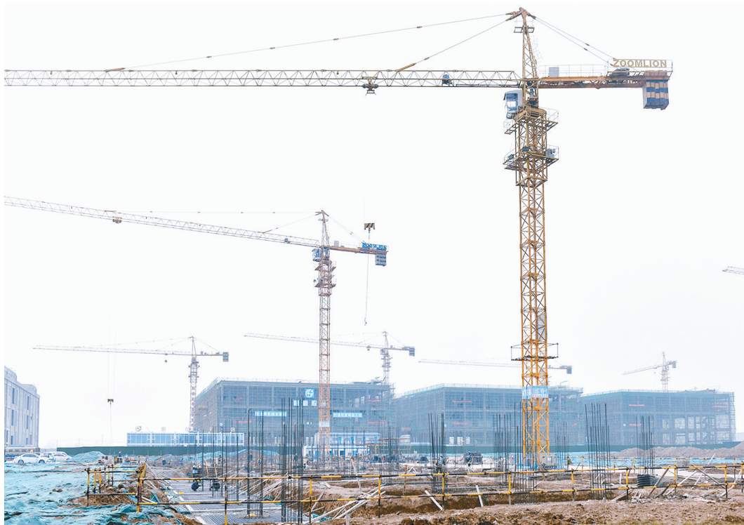
3月5日，河南食品科创园项目正在施工。
