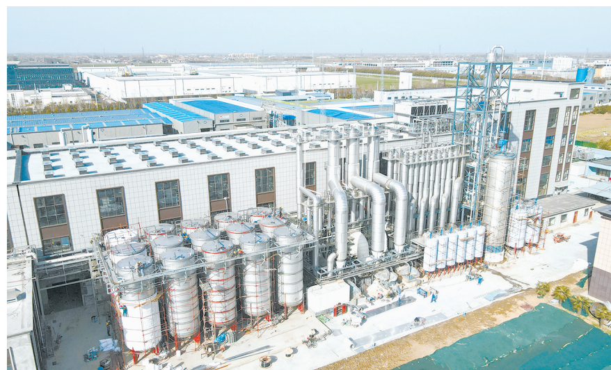
中大恒源D-阿洛酮糖项目现场，工作人员正在安装设备。
