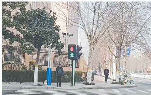
嵩山东支路与嫩江路交叉口西南角,人行道路交通信号灯异常。
