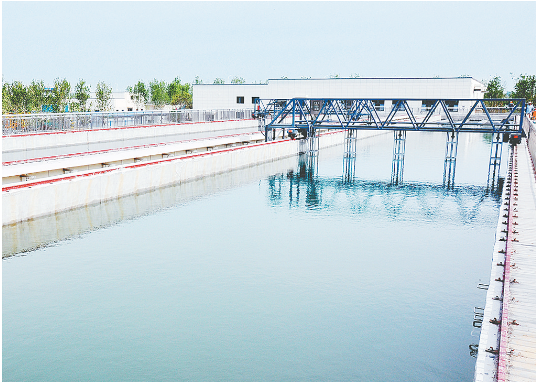
市第六水厂沉淀池
