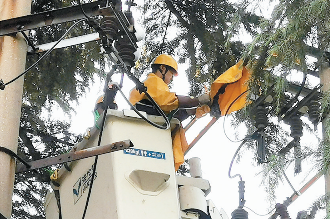
5月13日，检修人员对天山路供电设备进行检修。 连日来，漯河供电公司配电检修人员对市区输配电线路加强巡视和检修，并升级供电设备，及时消除安全隐患，确保夏季电网设备可靠供电。
