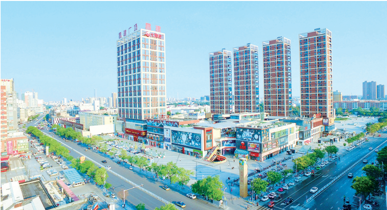
全市最大的城市综合体——昌建广场
