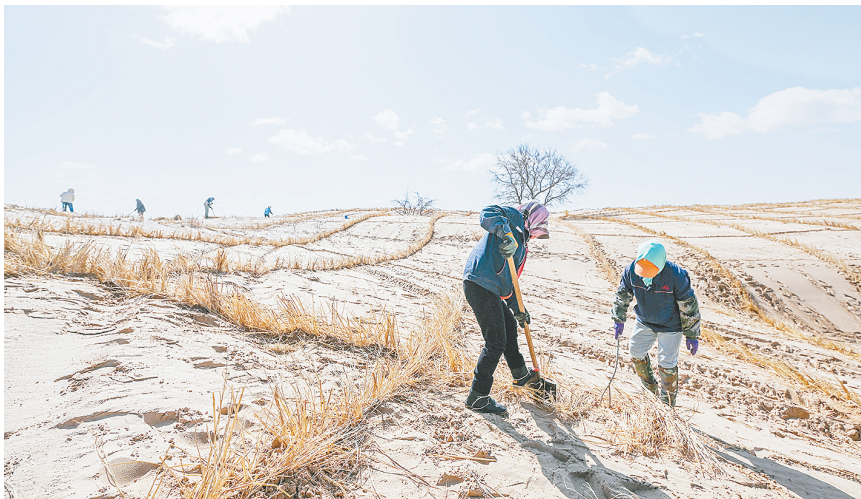
在通辽市科尔沁左翼后旗阿古拉镇,治沙工人在科尔沁沙地里打草方格(3月28日摄)。今年以来,内蒙古自治区全力打好“三北”工程攻坚战,加快推进防沙治沙工作,已完成防沙治沙604万亩。据预计,到2030年,内蒙古将新增完成科尔沁沙地沙化土地综合治理1100多万亩,可治理沙化土地治理率达到85%以上。
