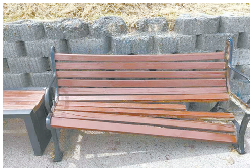
西城区银滩公园西南方向，多个座椅损坏。
