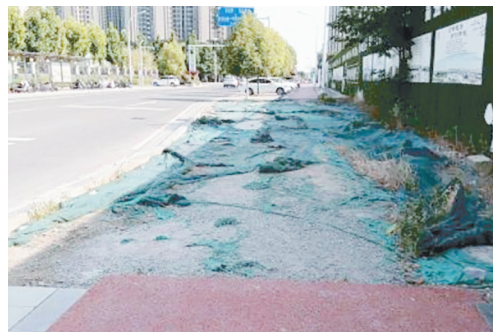
九龙山路与涇河路交叉口向南约60米至90米路西，围挡旁的绿网破损。
