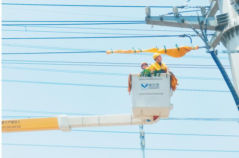
国网漯河供电公司配电带电作业班工作人员对10千伏I汇邓线和邓玉线进行改造。
