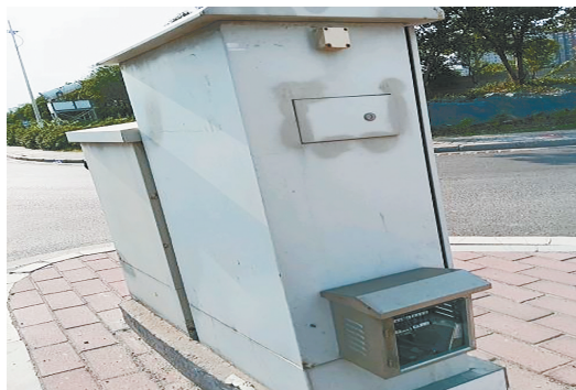
樟江西路与五一路交叉口向西约5米路北,安全岛上交通信号控制柜门缺失。
