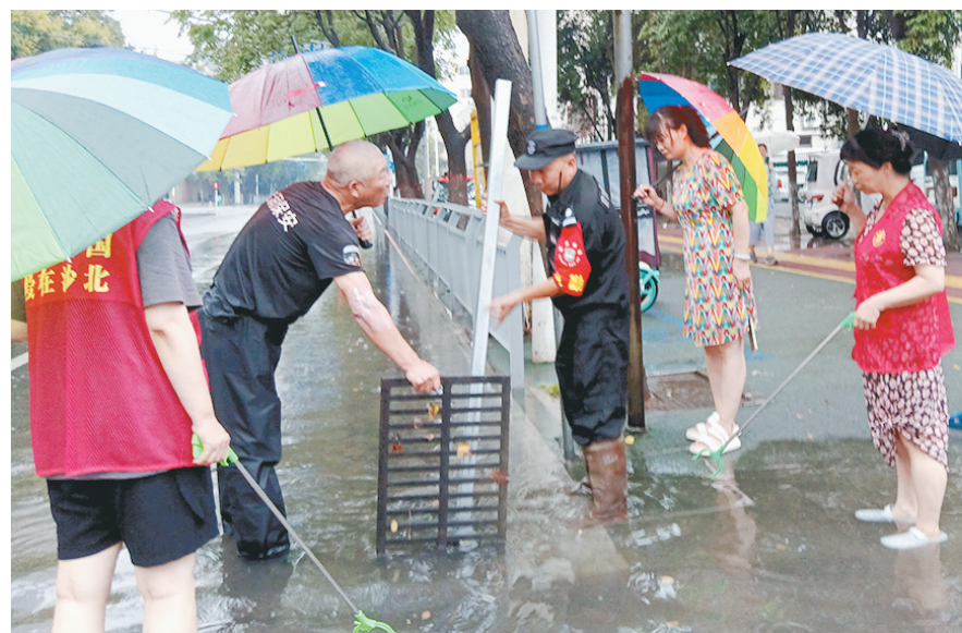
7月16日，郾城区沙北街道嵩山社区工作人员冒雨疏通下水道。 本报记者 张玲玲 摄
