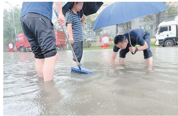
7月16日,市残联工作人员在漯河路与庐山路交叉口疏通下水道。 栗裕 摄
