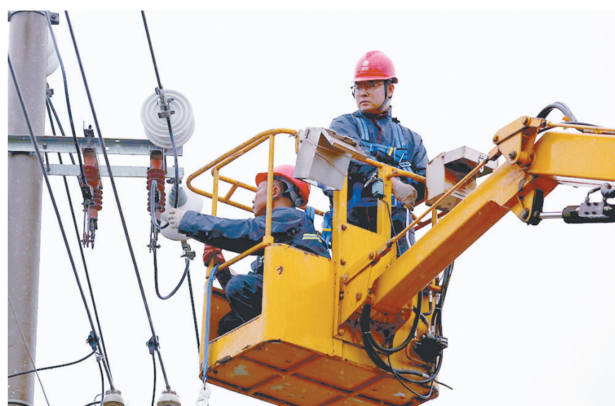
电力工人正在检修线路。
