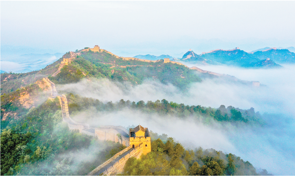
金山岭长城（2023年5月12日摄，无人机照片）。
