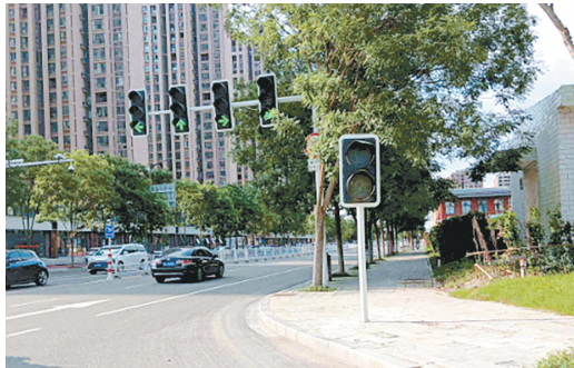
泰山北路与会展路交叉口东北角，人行道交通信号灯不亮。
