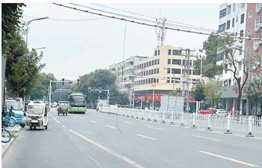
人民东路与解放南路交叉口向西约70米路北，主路面上通信线缆低垂落地。
