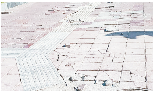
牡丹江路与金山北路交叉口东南角，地砖破损。
