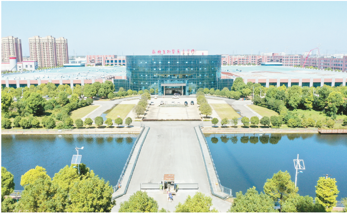
泰格生物医药产业园。
