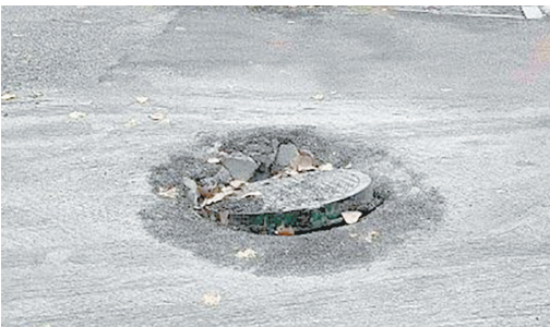
龙江东路与中山北路交叉口向东约140米路北，辅道北侧污水井盖沉陷。
