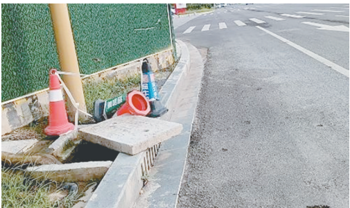
千山路与玉河路交叉口向北约10米路东，雨水井盖移位。
