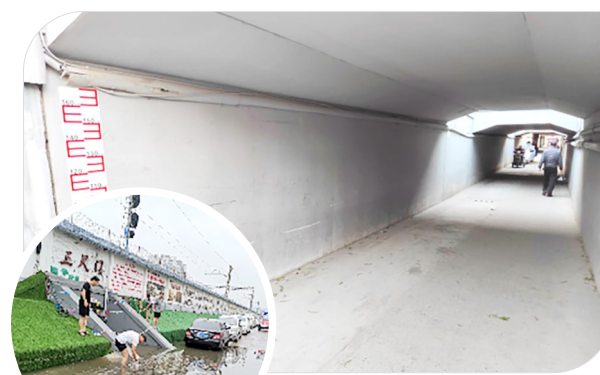
三尺门涵洞改造后
