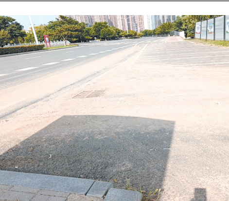
嘉陵江路与九龙山路交叉口向东约120米路南,路面脏污。
