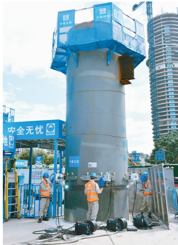
9月5日，工作人员遥控智能焊接机器人进行焊接作业。当日，10台智能焊接机器人在深圳湾超级总部基地C塔项目建设现场正式投入使用。本次投用的柔性焊接机器人由中国建筑自行研发，承担项目东塔10根直径2.5米外框柱、约7000吨钢构件的现场焊接任务。据介绍，C塔项目位于深圳市南山区深圳湾超级总部基地中心，最高高度400米，设计为连廊双子塔结构，是深圳市首批重点智能建造试点项目之一。
