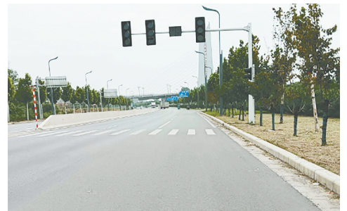
樟江东路与桐柏山路交叉口，四个方向的交通信号灯缺失。
