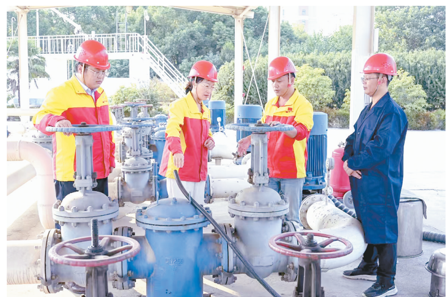
近日，源汇区纪委监委联合区委办到漯河中油销售有限公司开展安全生产督导检查。图为源汇区纪委监委工作人员（左一、左二）、区委办工作人员（右一）在该公司设备区了解企业安全管理情况。 本报记者 姚肖摄
