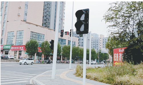
长江路与王屋山路交叉口西南角，交通信号灯异常。
