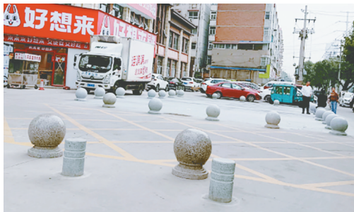
交通北路与黄河中路交叉口向北约100米路东，门面房前，隔离墩乱堆放。
