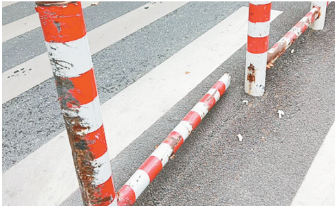
海河路与岷山路交叉口向西约120米,交通护栏损坏。
