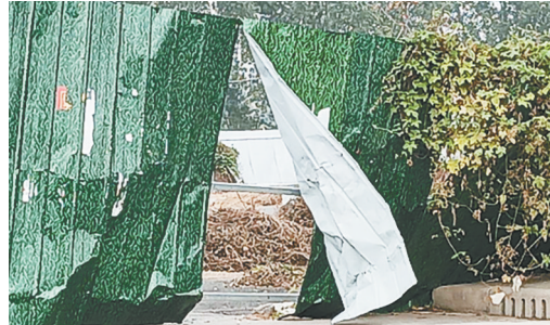
天柱山路与黄河东路交叉口向南约300米路东,围挡破损。
