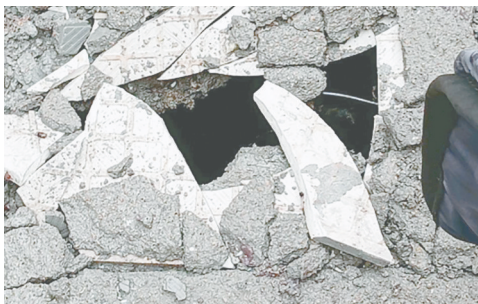
翟庄主街与人民东路交叉口向北约10米路西，污水盖板破损。
